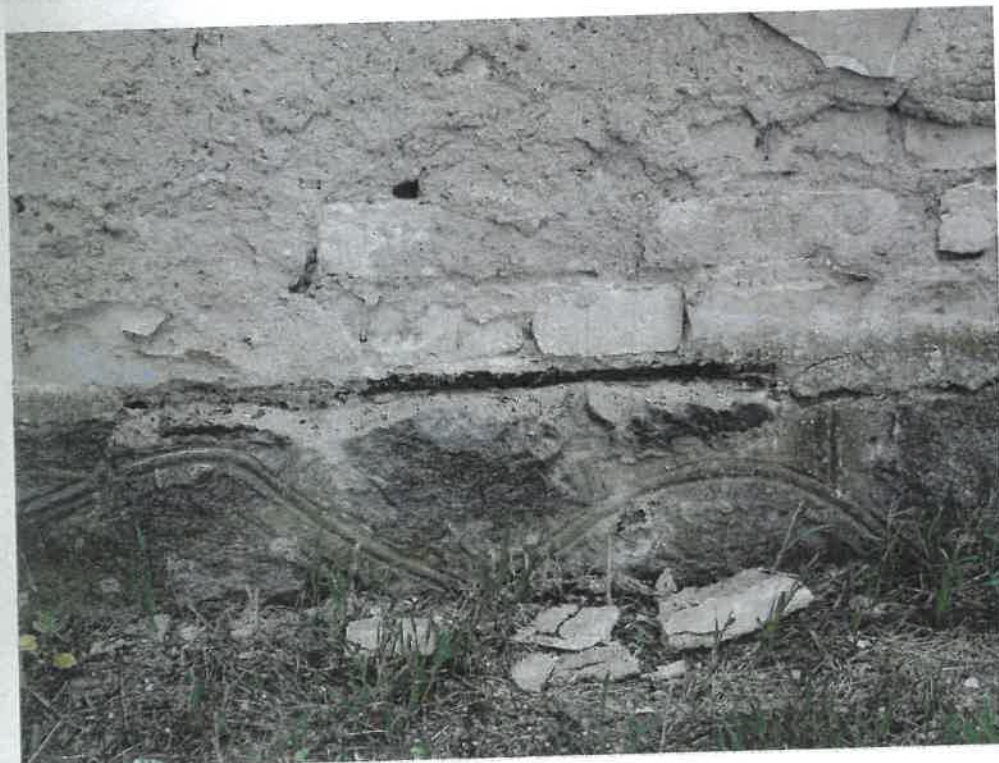
Izolacja pozioma ściany fundamentowej z piasku nasączonego roztworem smołowym.
